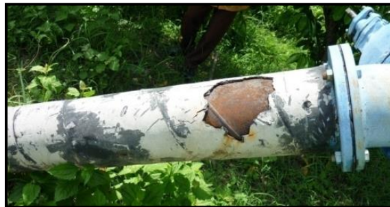
Gambar 5. Kondisi Pipa pada Head Pompa
