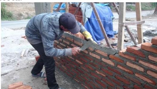
Gambar 6. Pemasangan Bata Merah
